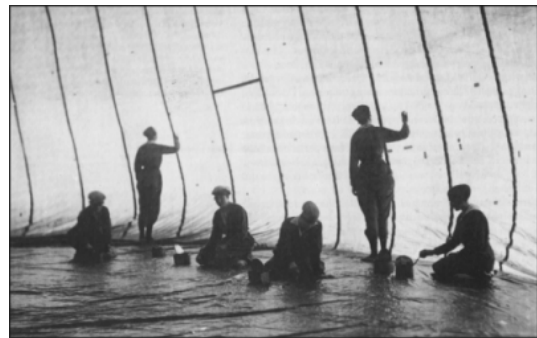
Vérification de l'étanchéité des parois. BBC Hulton picture library, London
