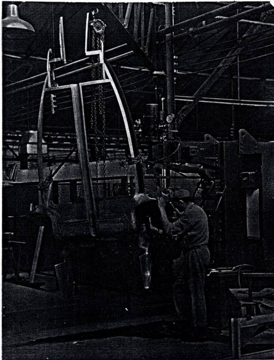
Soudure du soubassement
