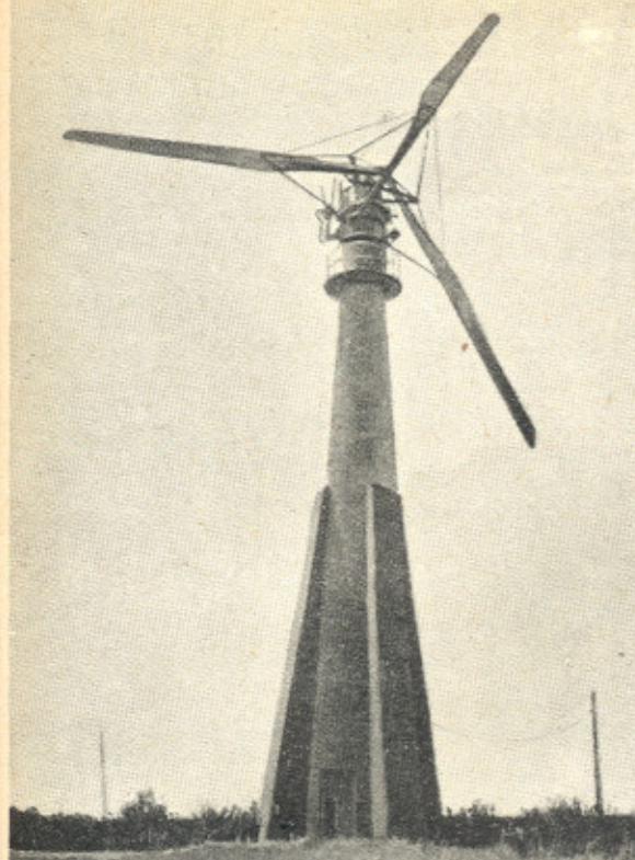
L'aéromoteur danois Smidth de 70 kW a une hélice de 24 m de diamètre. Marchant de jour seulement, un de ces modèles a fourni 118 729 kWh en 1947. Tous ensemble, ils ont fourni plus de 3 millions de kWh en 1943.
