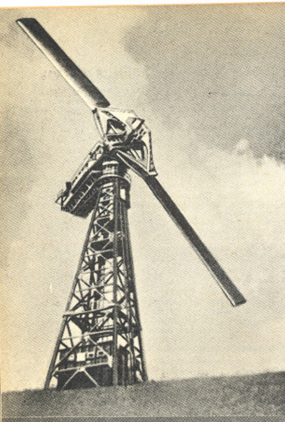
L'éolienne expérimentale Smith-Putnam édifiée à Grandpa's Knob (E.-U.), en 1941. D'une puissance nominale de 1 500 kW, la partie mobile en pesait 265 t. Une pale de l'hélice de 55 m. de diamètre se brisa en 1945.
